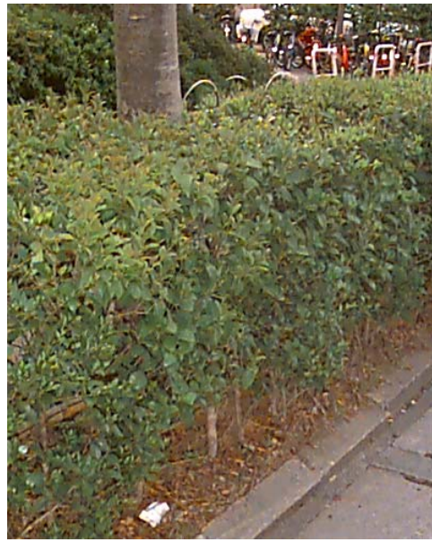
写真2 2号棟東側のケヤキの根の 成長により道路側に押しやられた 縁石ブロック
