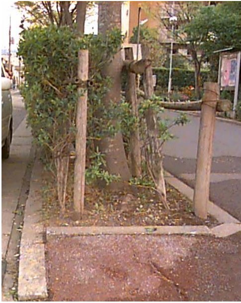
写真1 2号棟東側のケヤキの根の 成長によりひび割れたカラー舗装, 道路側に押しやられた縁石ブロック
