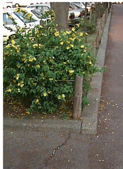
写真4 1号棟とごみ集積所のひび割れ
