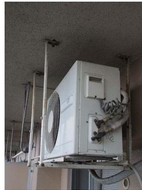
ベランダ天井面にエアコン室外機を吊り下げる吊下げ金物の錆が目立つお宅があります。エアコン関連は居住される方の管理となり、腐食の進行防止と美観維持のため、塗装が必要で
