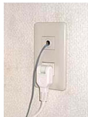
図 33 ドアホンコンセント 上: ドアホン用ケーブル、 下: 機器用コンセント
