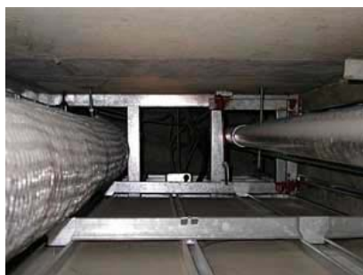
〔廊下の天井裏（奥が玄関部分）〕
