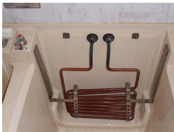
図10 バスヒーター(標準ユニットバス)
