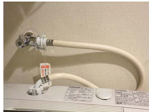
〔洗濯機用水栓(TW11)取付けの例〕
