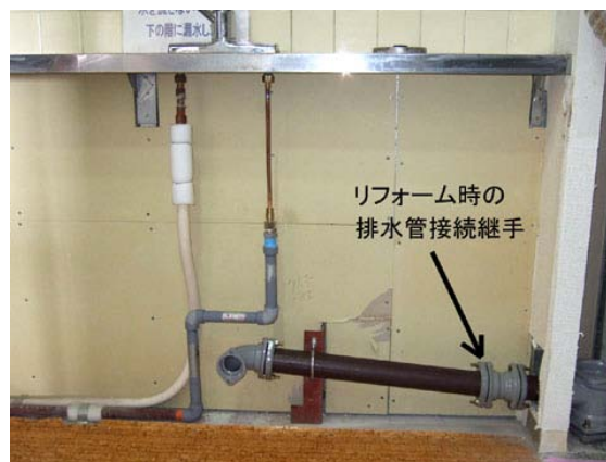
図 22 リフォーム時の排水管継手
