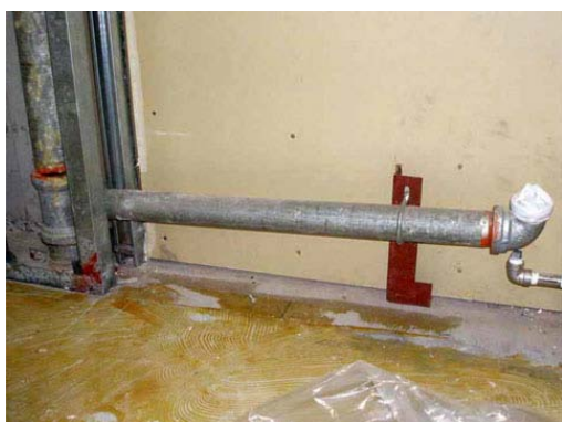
左側：縦排水管、右側：排水横引枝管 [ キッチン系統排水管 ] (2007 年)
