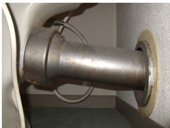
図 18 洗い落とし式の配管
