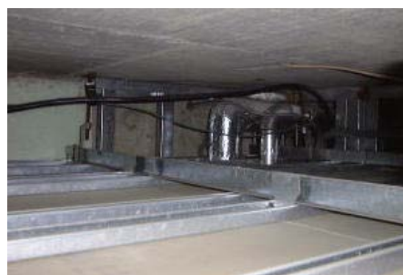
〔洗面所の天井裏〕
