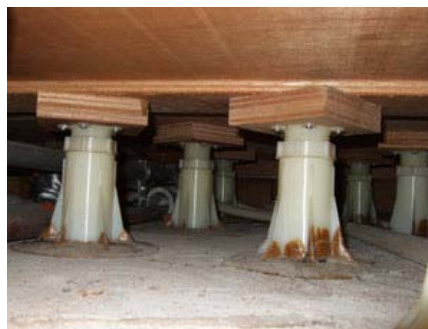
【洗面所床下の支柱】
