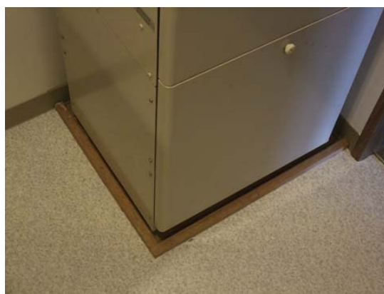
図 50 TES 下のクッションフロアの見切り用の板
