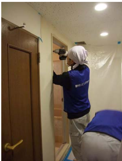
洗面所の養生後、解体開始
