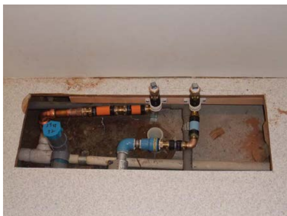
床下の配管を改修した状態
