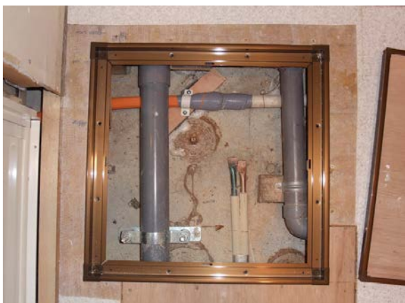
洗面所に設けた点検口下の配管
