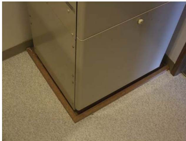
図 20 TES 下のクッションフロアの見切り用の板
