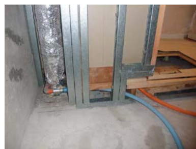
新しい UB のための給水管 （青）、給湯管（オレンジ） を接続した状態。
