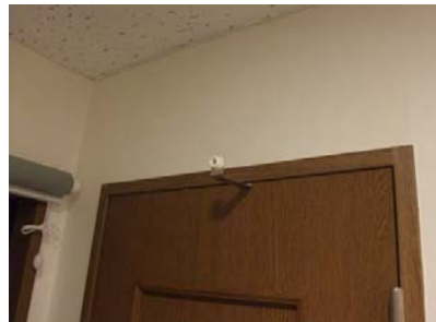
移設したトイレのドアストッパ
