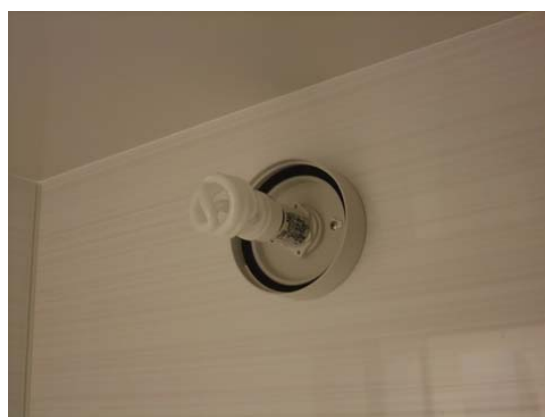
電球形蛍光ランプ EFD15EL/12-HS (三菱電機オスラム(株)、12W)
