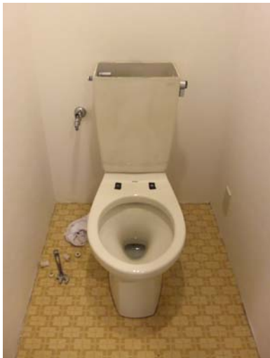
1) 既存のトイレ(撤去前)
