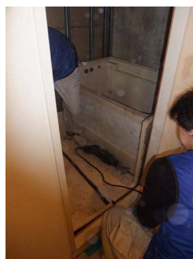
電動ノコで切断、解体
