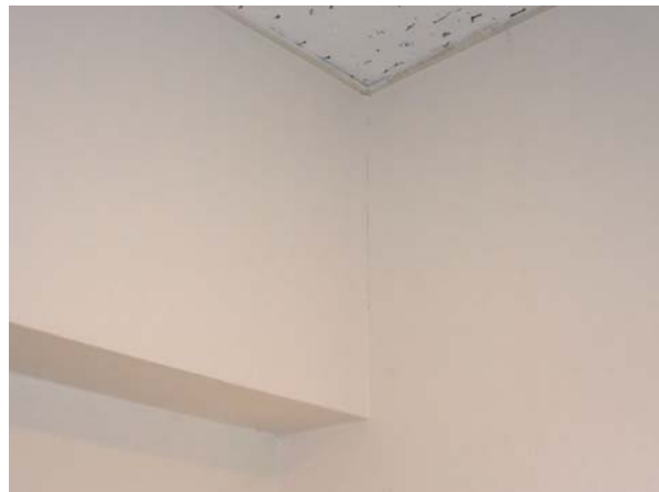
壁クロス張替え後
