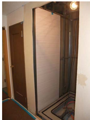
新しいユニットバスの壁面 パネルの取付開始
