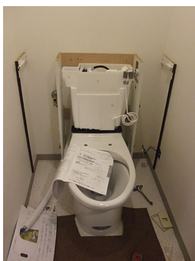
5) タンクの取付
