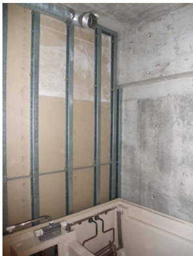
壁が撤去された浴室内
