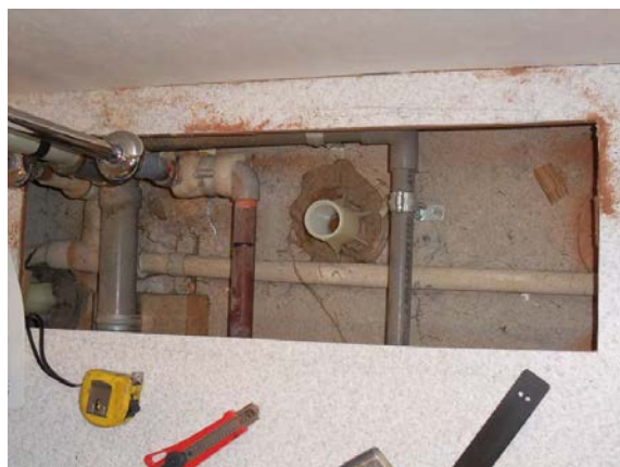
洗面化粧台 LC の配管位置に合わせるために床面を大きく開口
