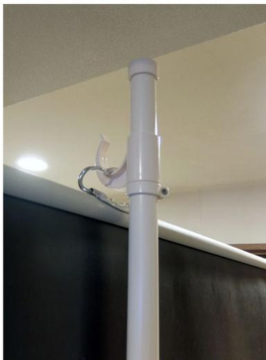
スクリーンの引き出し金具の高さの調整に対応
