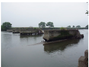
①(旧) 流山橋橋脚基礎
